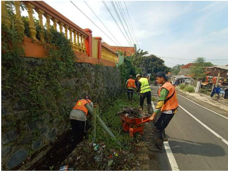
Kegiatan NGAPLING (Ngaspal Keliling) dilaksanakan pada tanggal 18 februari 2025, kegiatan dilaksanakan dengan melakukan pengeprasan bahu jalan dan normalisasi saluran drainase di ruas jalan ranu klakah - ranu pakis.
